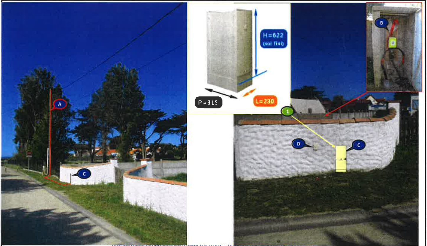
La solution technique est déterminée dans le respect de la norme NFC 14-100 en vigueur. Photo compteur non contractualisée
